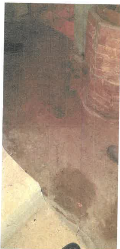
Fot.4 Zawilgocenia w piwnicy
