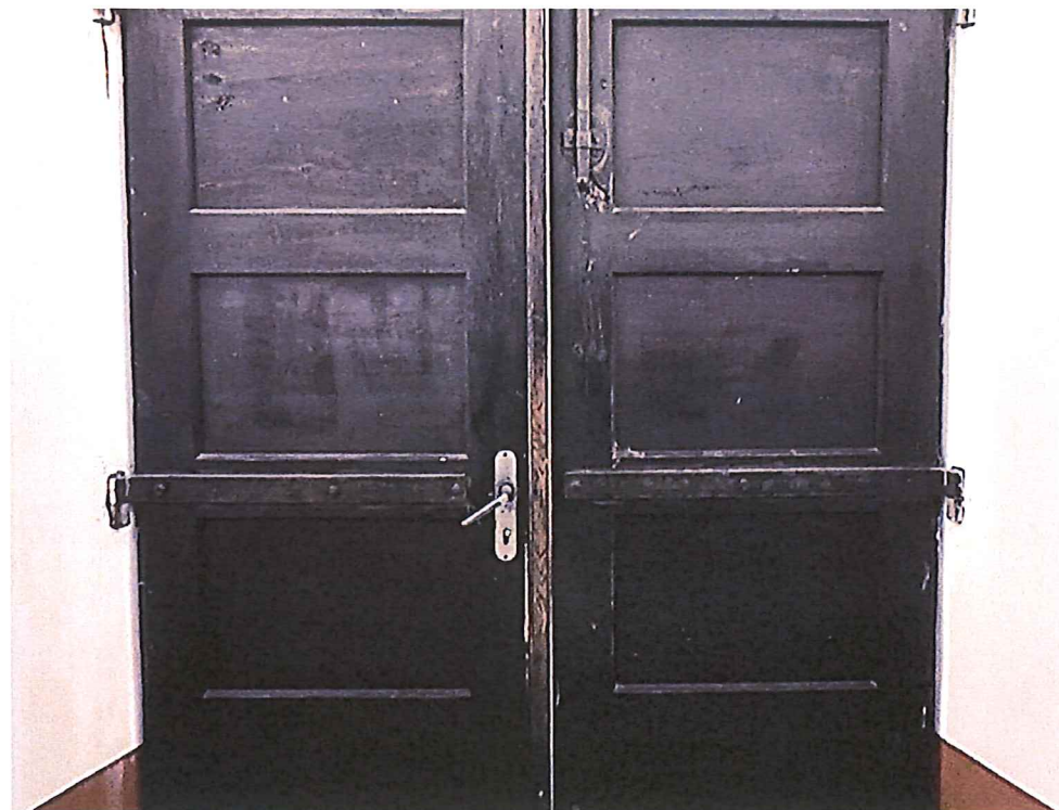
Fot. nr 12 Kościół parafialny pw. św. Franciszka Salezego i św. Andrzeja Boboli w Gorzycach. Widok zniszczeń mechanicznych powierzchni drewna strony wewnętrznej drzwi głównych.
