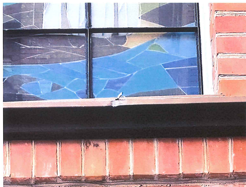
Fot. nr 10 Kościół parafialny pw. św. Franciszka Salezego i św. Andrzeja Boboli w Gorzycach. Widok uszkodzonej obróbki blacharskiej okapnika podokiennego naw bocznych.
